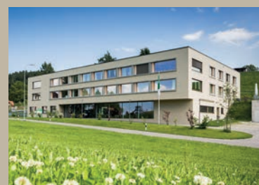
Wohnheim Krone, Walzenhausen
