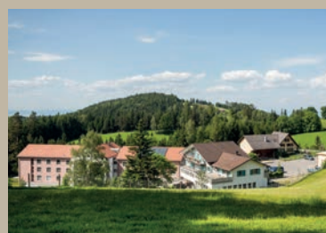
Wohnheim Bellevue, Walzenhausen
